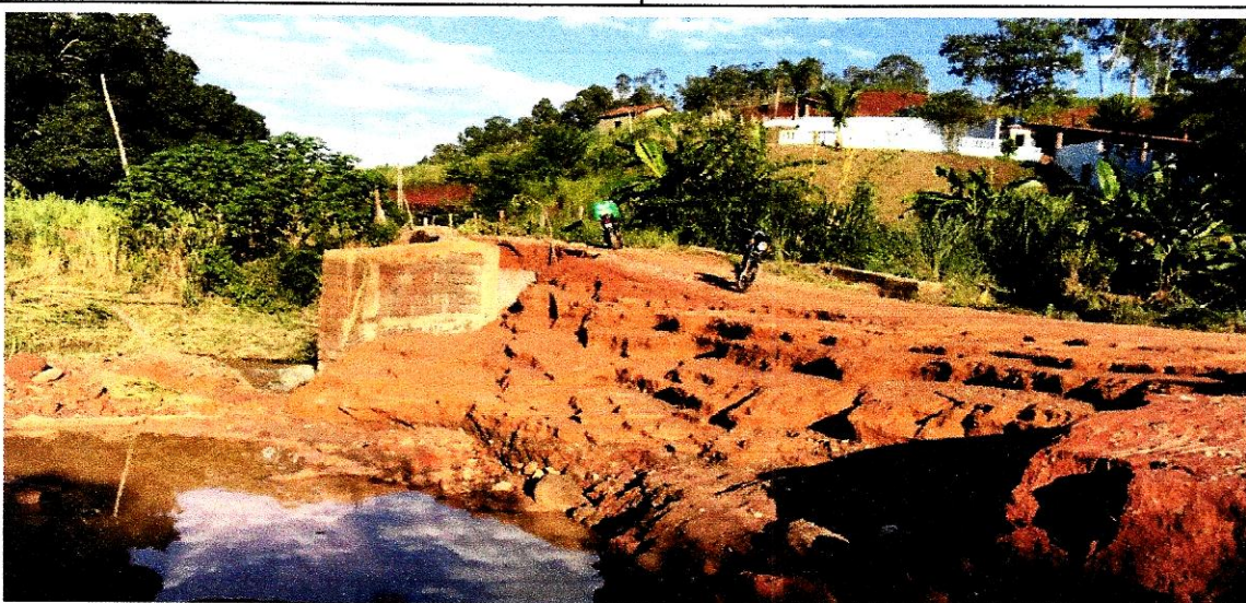
Ponte Gumercino Gomes de Freitas, localizada no Córrego dos Barbosas e Elias. Santa Maria, Zona Rural de Visconde do Rio Branco - MG
